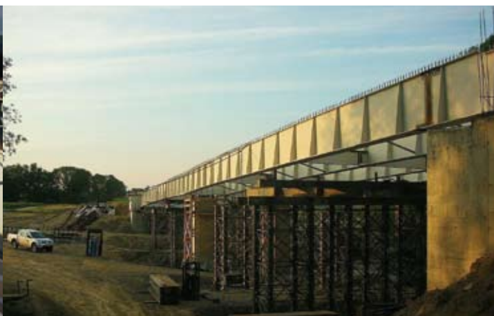
most přes Černý potok v km 3,720
