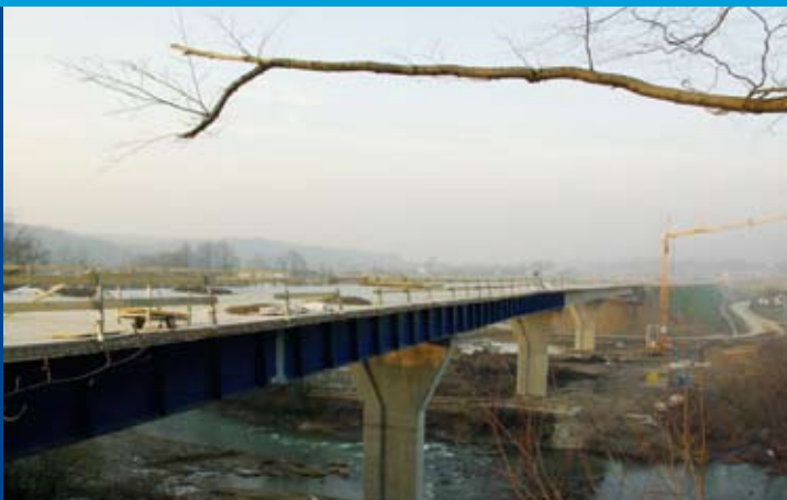
most přes Oši v km 1,528 stavby
