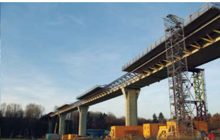
údolní estakáda v km 4,367–4,799, betonáž – pohled k Trinci
