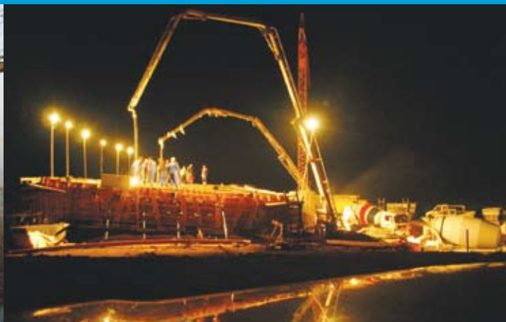
most přes silnici I/11 v km 3,001 – noční betonáž mostovky
