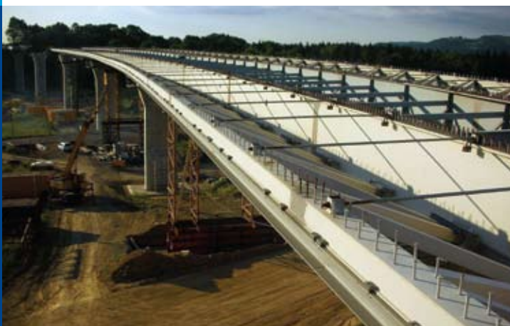
údolní estakáda v km 4,367–4,799, montáž ocelové konstrukce
