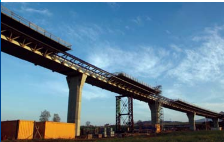
údolní estakáda v km 4,367–4,799, betonáž – pohled k Žilně
